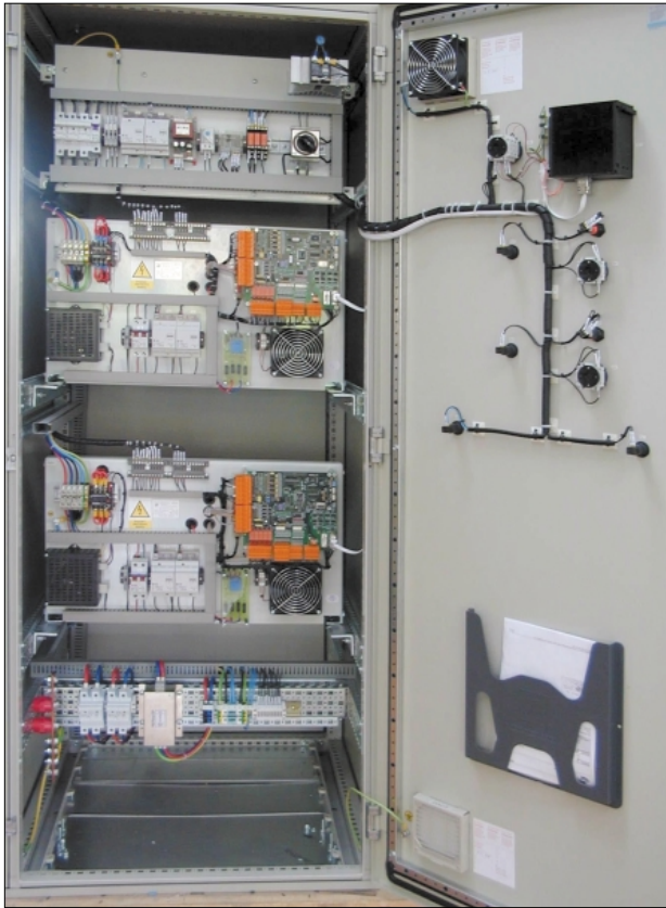
Obr. 2. Pohled na otevřený rozváděč zdroje EZZT se dvěma moduly
